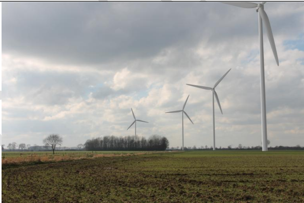
Figuur 19 Windpark op een afstand van 5 keer de tiphoogte; de windturbines zijn beeldbepalend en zeer dominant aanwezig.
